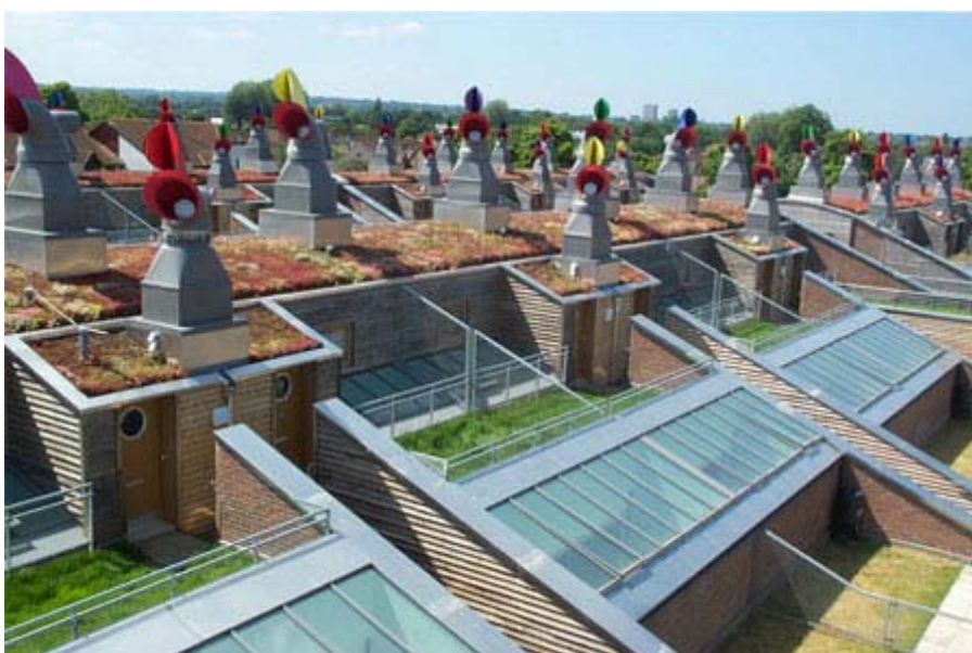
Toitures et terrasses végétalisées et cheminées ludiques du système de ventilation naturelle
