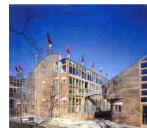
Toitures et terrasses végétalisées et cheminées ludiques du système de ventilation naturelle
